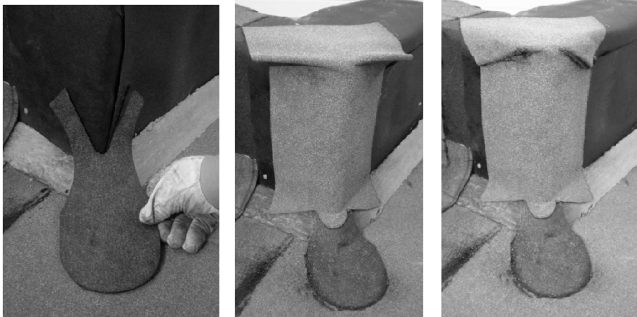
Obrázek /9/ Natavení univerzální tvarovky 1 a 2
