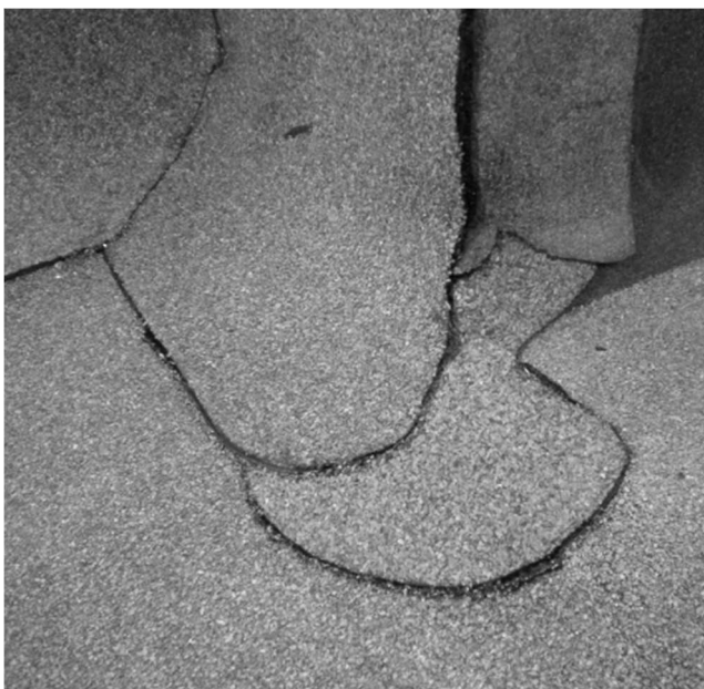
Obrázek /14/ Detail vnějšího rohu a natavení rohové tvarovky 2a (při použití univerzální tvarovky 4 s posypem nemusí rohová tvarovka 2a a 2b na sebe navazovat)
