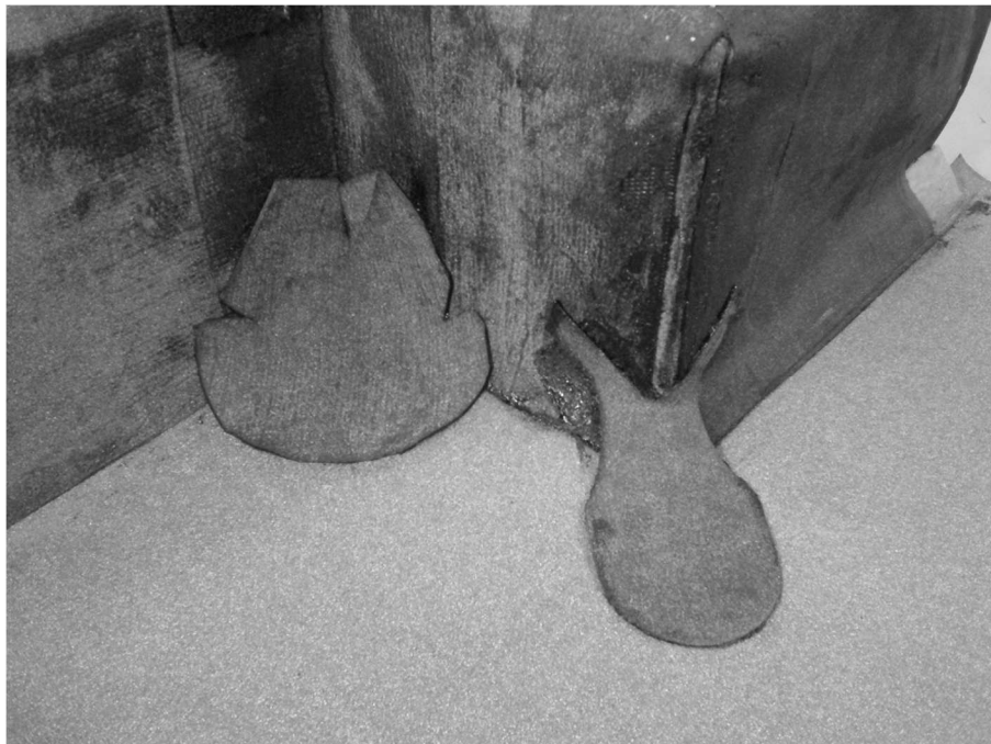
Obrázek /15/ Natavení univerzálních tvarovek 1 a 3 (bez posyspu), asfaltový pás z plochy je přiveden k detailu
